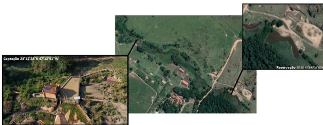
Fig. 03: Ponto de captação e reservação do Ribeirão Ingá. (Prefeitura de Salto SP, 2024)
