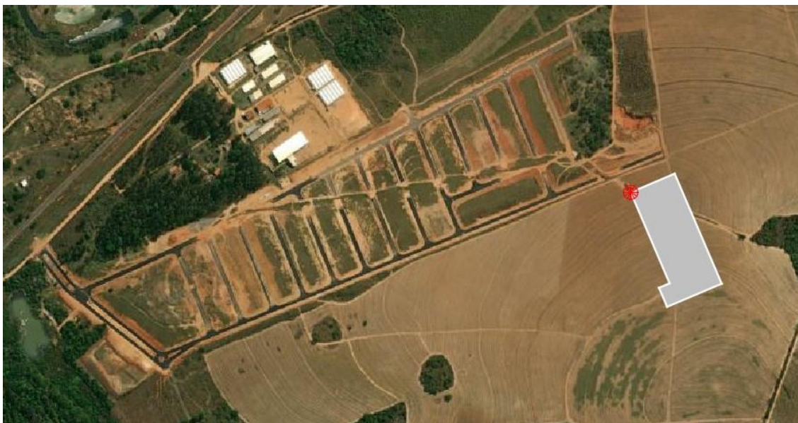
Fig. 07. Local de Implantação ETA - Pedra Branca (anteriormente nomeada Piraí).(SAAE Salto, 2024).
