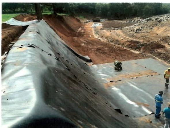
*Figura 58 - Obra De Impermeabilização Com Geomembrana PEAD*
