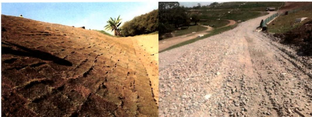
*Figuras 49 e 50- Plantio De Grama No Talude E Estrada De Acesso À Área De Aterramento*
