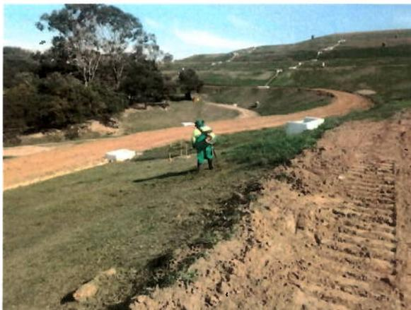
*Figura 59- Roçada Mecanizada Para Manutenção Dos Taludes*
