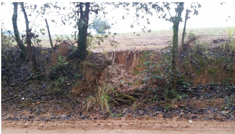
Figura 22 - Encaixamento na lateral da estrada SLT 413.
