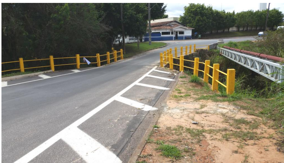
Figura 7 - Ponte de concreto localizada na avenida Brasília, no início da área urbana do município de Salto.
