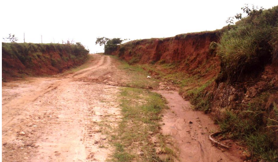
Figura 10 - Ponto crítico de encaixamento da seção da via.
