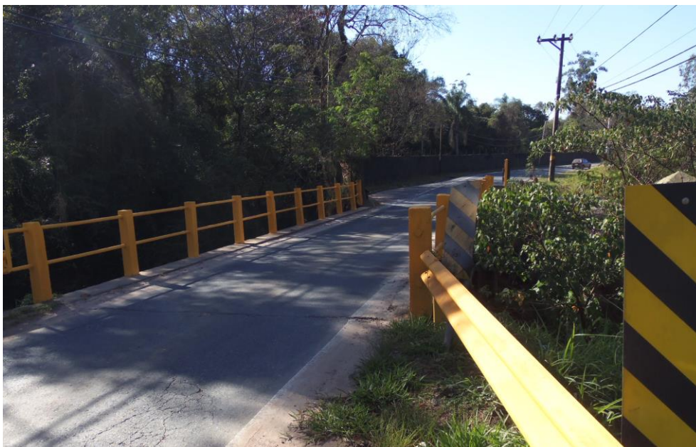
Figura 15 - Ponte de concreto localizada da avenida José Maria Marquês de Oliveira.
