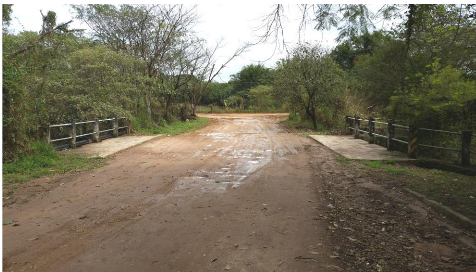
Figura 8 - Ponte de concreto com área de passeio e barras de segurança devidamente implantadas, localizada na Rua Trentino.
