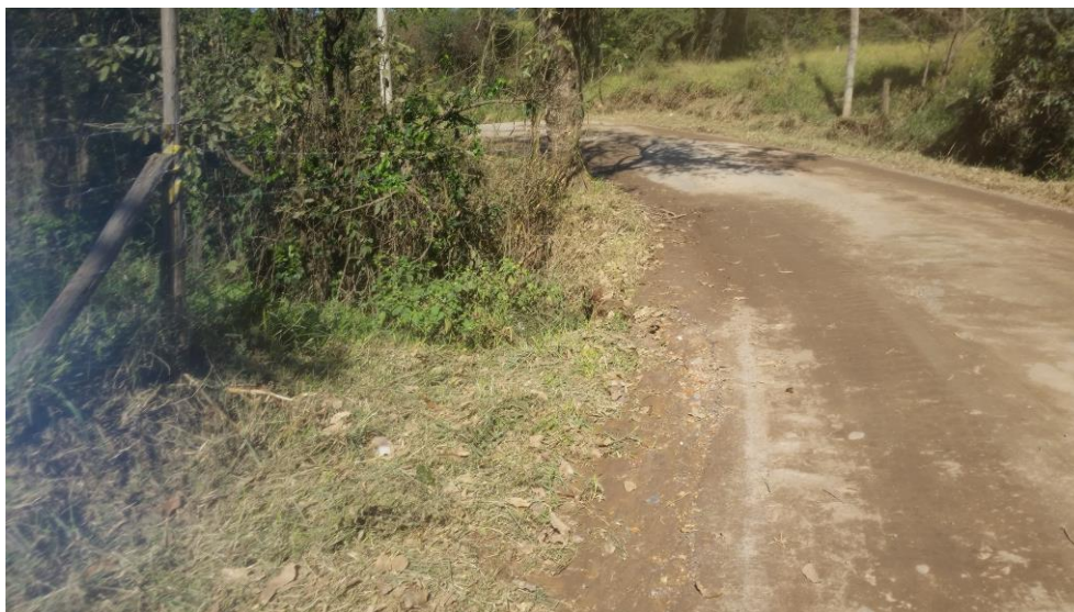
Figura 18 - Tubulação localizada na estrada SLT 161.
