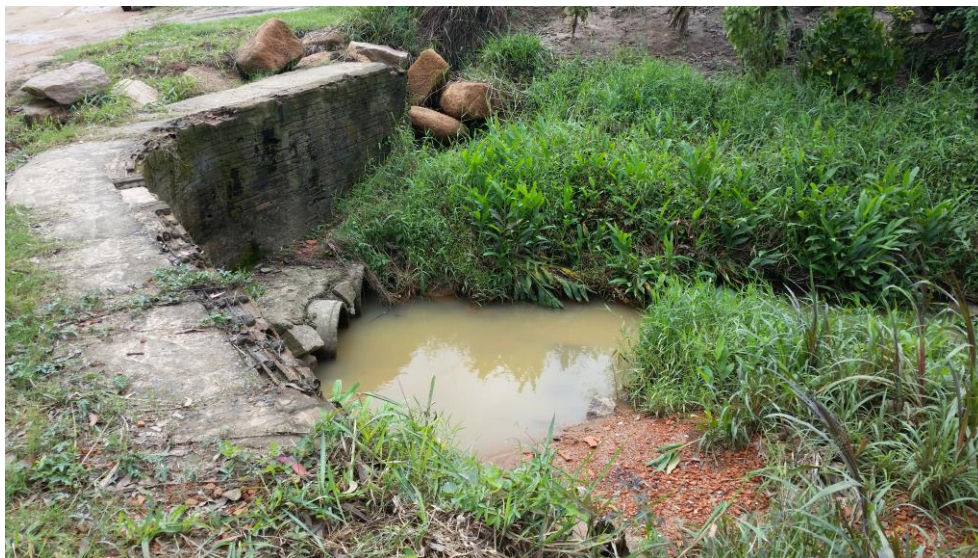
Figura 17 - Tubulação localizada na estrada SLT 249.
