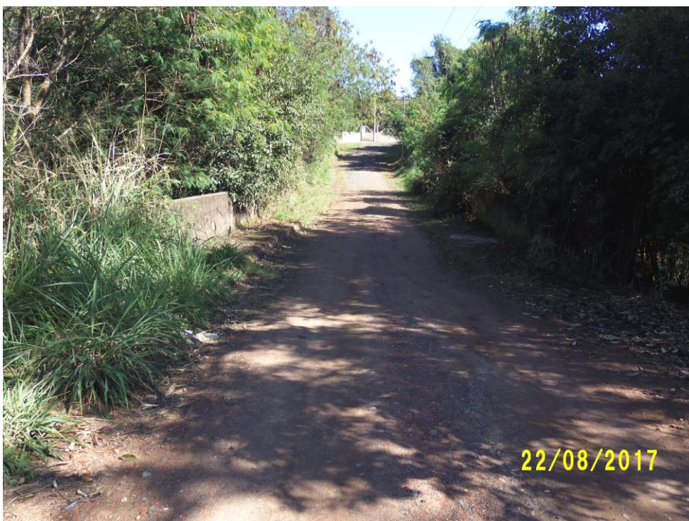
Figura 14 - Ponte de concreto localizada na estrada SLT 010.
