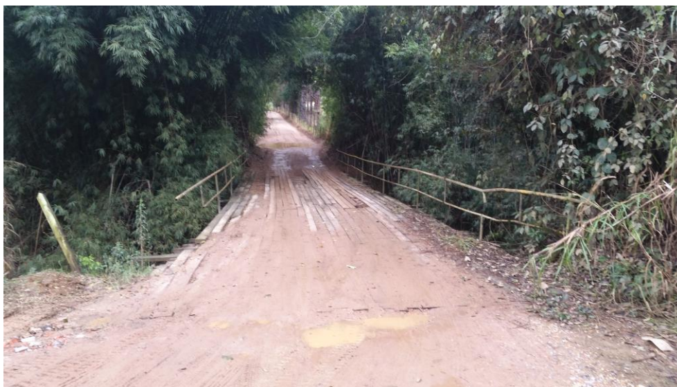
Figura 4 - Ponte de madeira localizada na estrada SLT 426.
