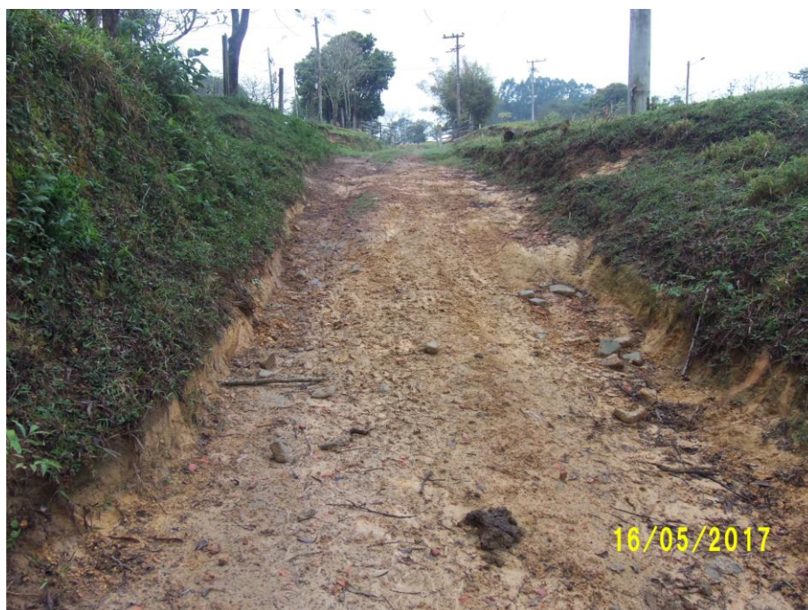
Figura 23 - Ponto crítico de intenso encaixamento nas laterais da estrada SLT 413.
