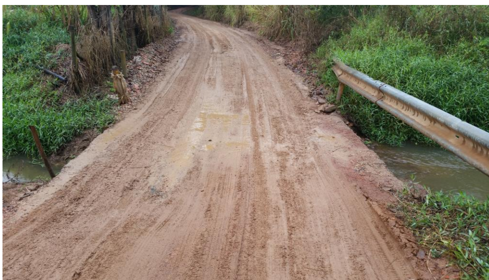
Figura 3 - Ponte de concreto localizada na estrada SLT 413, apresentando barra de segurança em um dos lados.
