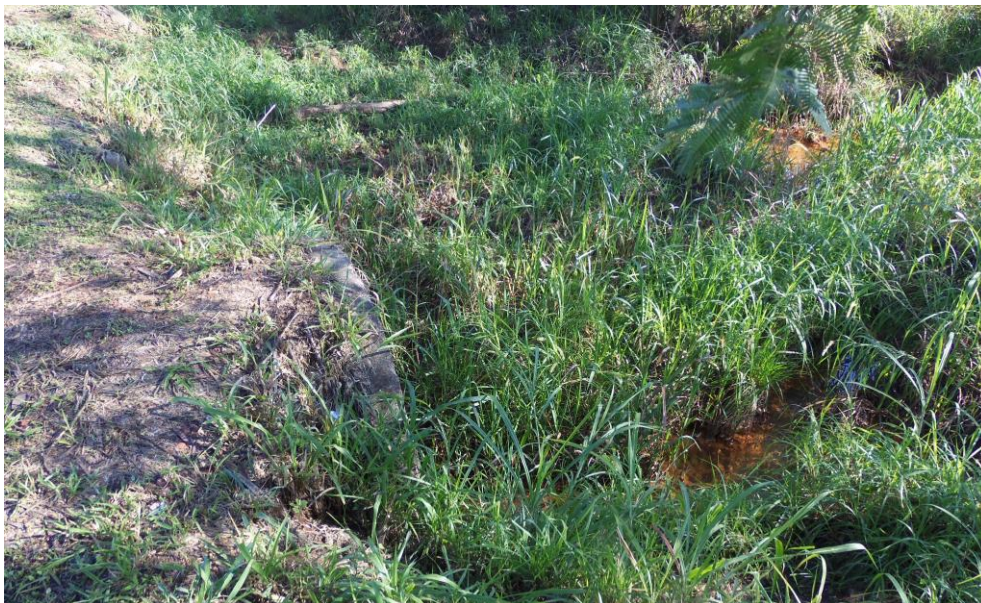
Figura 19 - Tubulação localizada na estrada Itapecirica.
