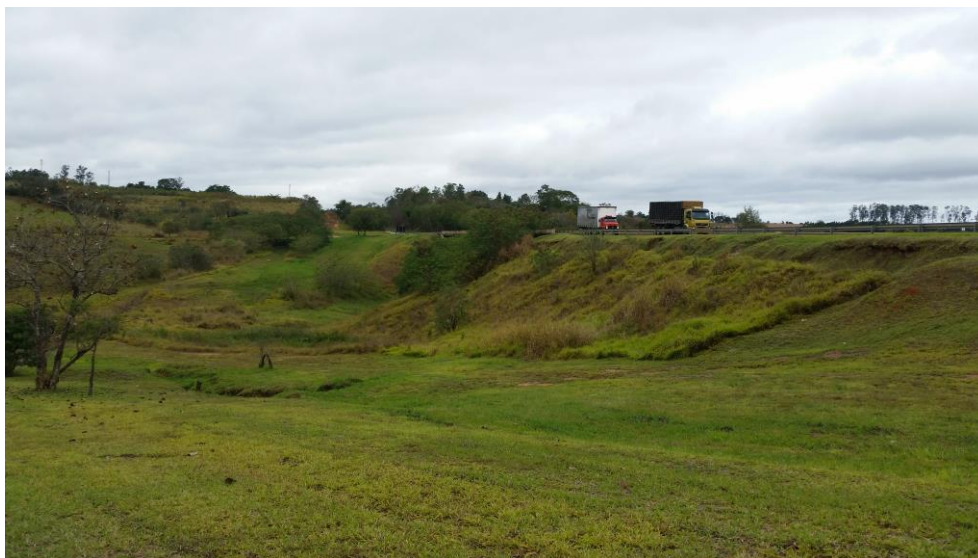
Figura 13 - Vista longínqua da ponte de concreto localizada na SP-308.
