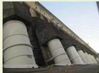
Dutos da Hidroelétrica de Itaipu
