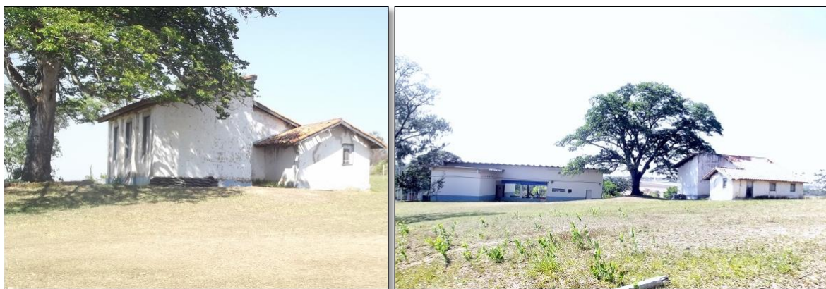
FIGURA 41 - À esquerda a escola construída em 1920. À direita, as duas escolas
