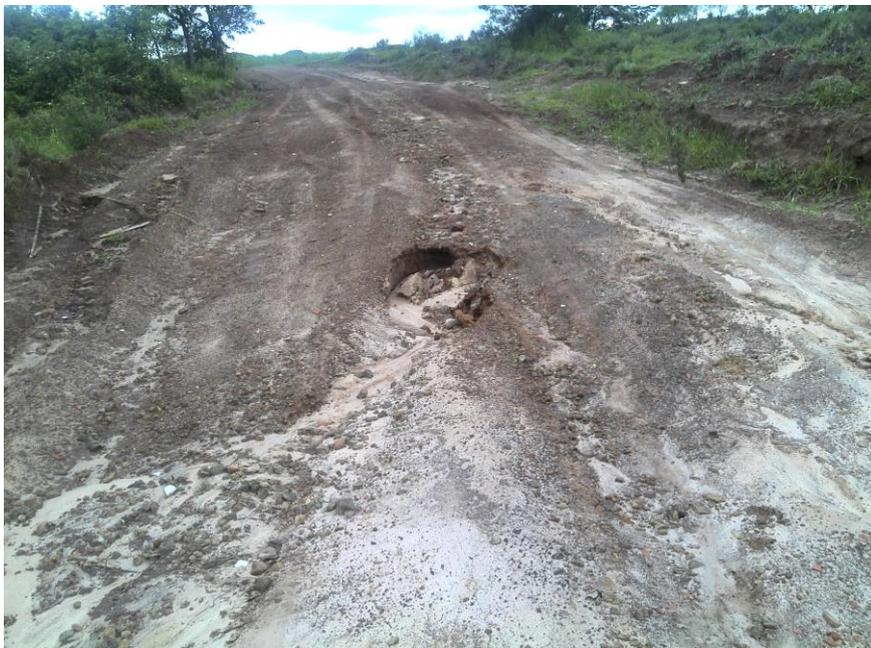
Figura 20 - Ponto crítico de erosão no leito carroçável da estrada.
