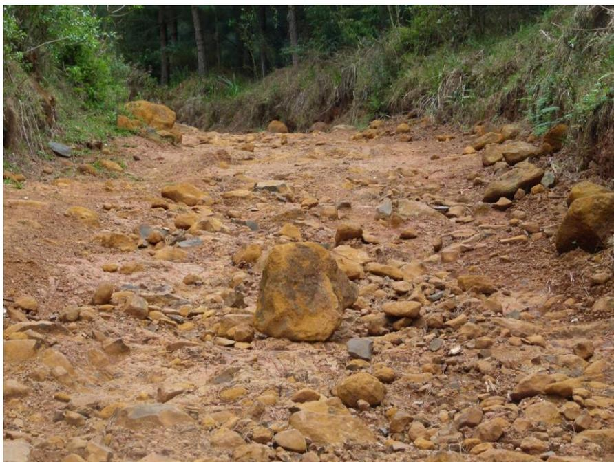
Figura 6 - Ponto crítico severo de afloramento de rocha.
