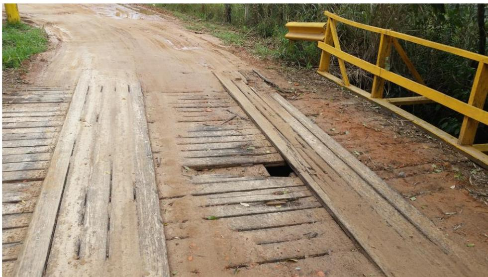
Figura 12 - Ponte de madeira com base metálica localizada na estrada SLT 249, a estrada apresenta pequenas avarias nas tábuas de madeira no leito carroçável.
