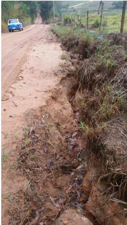
Figura 26 - Intensa erosão encontrada em outro trecho da estrada SLT 413, nota-se que a erosão em questão ainda está em processo de formação.
