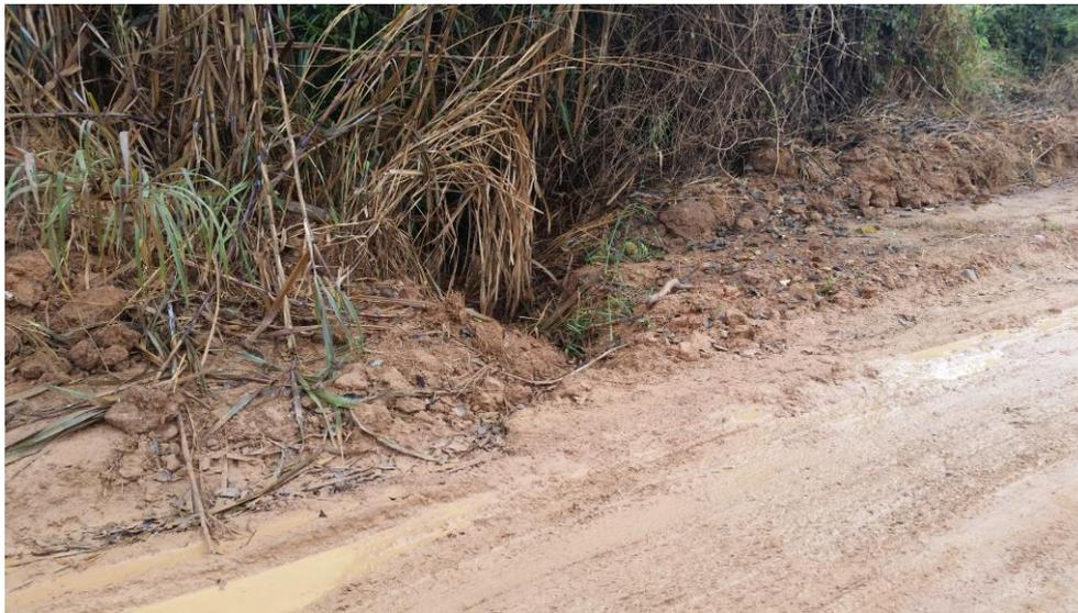
Figura 21 - Pequena erosão na lateral da estrada SLT 249.
