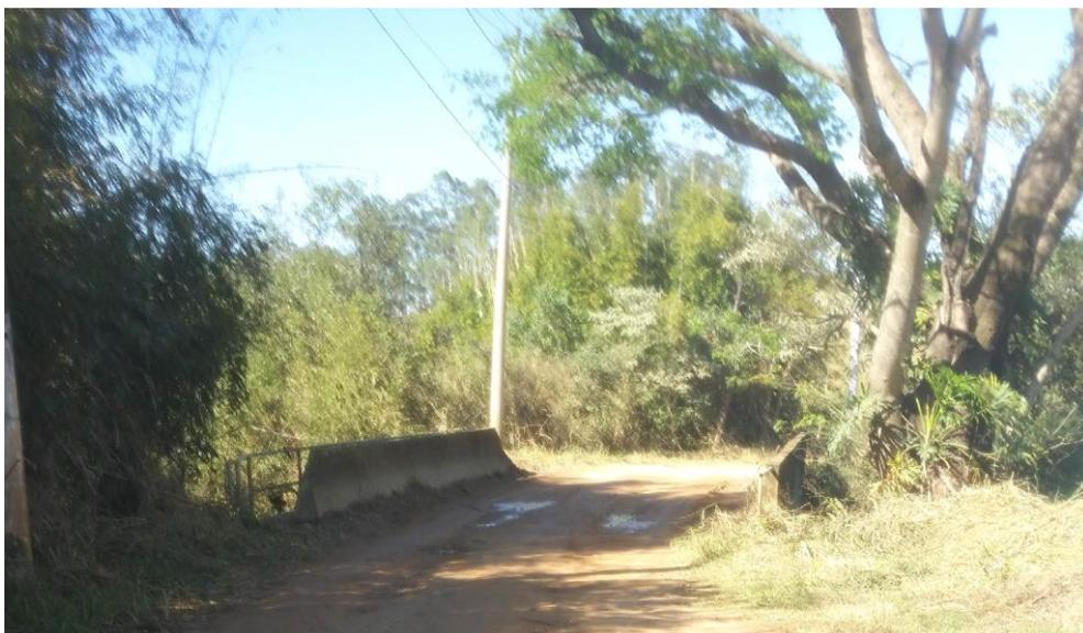
Figura 11 - Ponte de concreto localizada na estrada SLT 161 com ponto crítico de empoçamento no leito carroçável.
