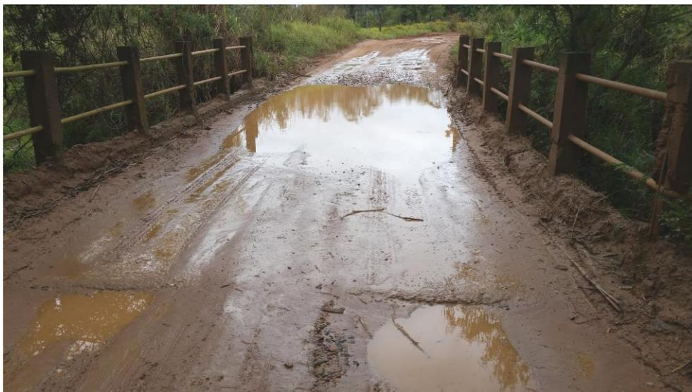
Figura 5 - Ponte de concreto com intenso empocamento no leito carroçável localizada na estrada SLT 426.
