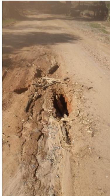
Figuras 9 e 10 - Ponte de madeira localizada na estrada Porto Góis, com intensa avaria na extremidade superior.
