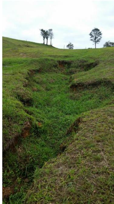
Figura 24 - Intensa erosão na lateral da rodovia SP-308.
