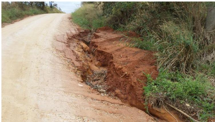
Figura 25 - Intensa erosão localizada na lateral na estrada SLT 413.
