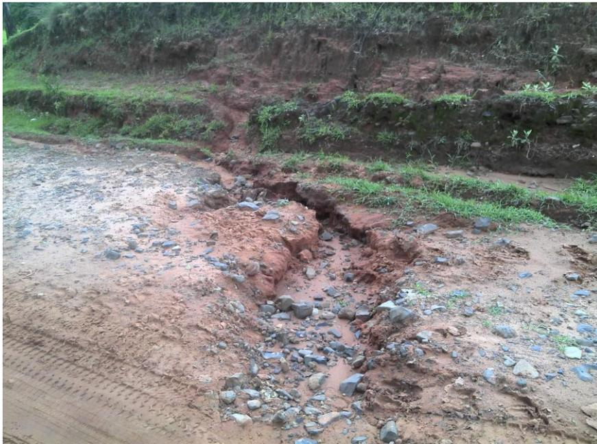
Figura 19 - Ponto crítico de erosão nas sarjetas da estrada.
